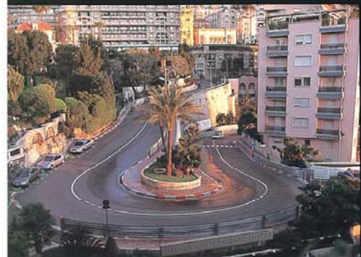
年に一度、F1パイロットがコーナリングの技術を競うモナコグランプリ。この時期はグランプリではなく、このコースとなる道路ではガードレール取り付け作業、並走場ではピットの建設が急ピッチで進んでいた。
