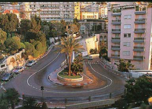
常に一貫、F1パイロットがコーナリングの技術を競う競走コースヘアピン。この時期はグランプリまであと1ヶ月だった。コースとなる道路ではガードレール取り付け作業、決止場ではピットの建設が急ピッチで進んでいた。
